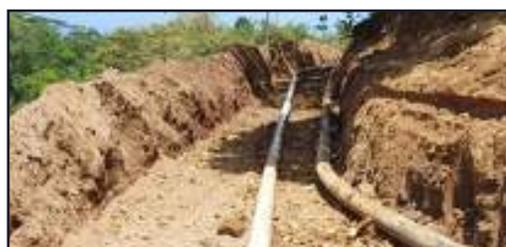
*Entierro de tubería en derecho de vía en calle hacia Cortijo*
